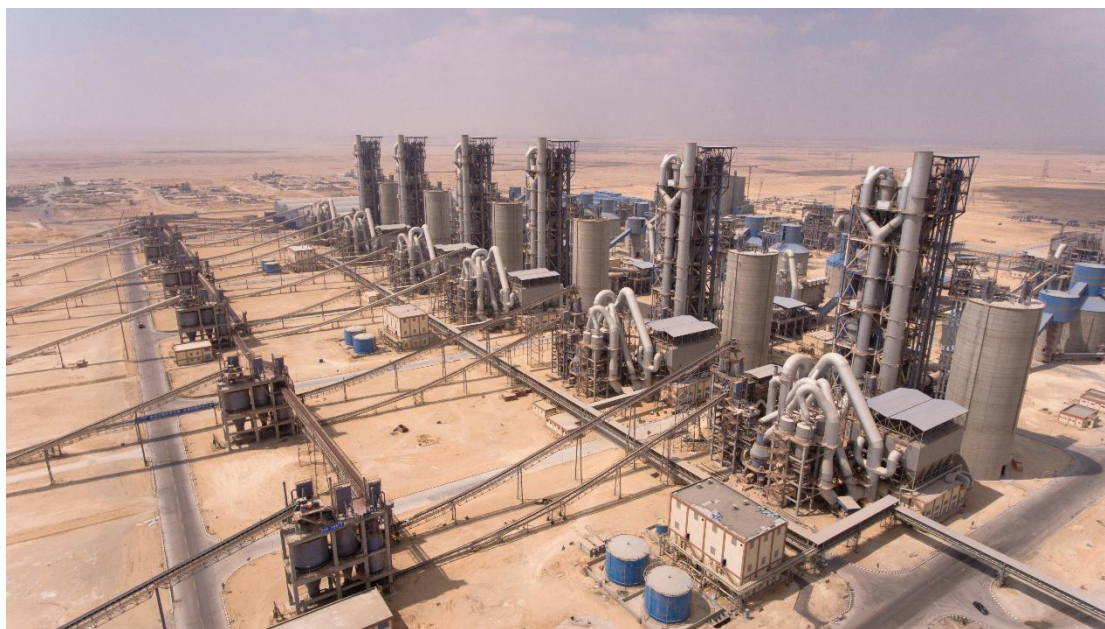
图 1：埃及 GOE Beni Suef 项目全景
